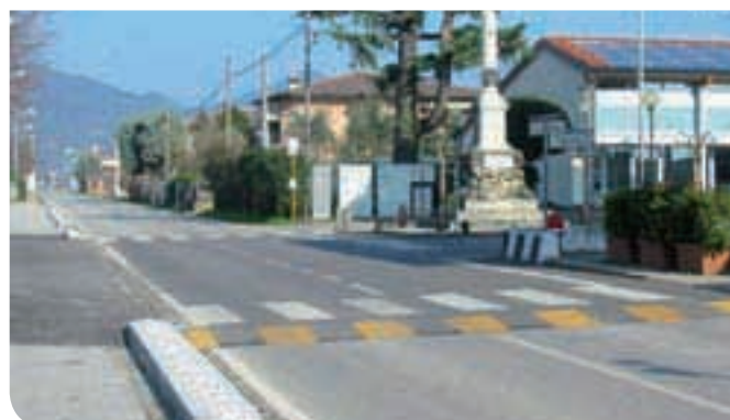
2011 - 2013 Dossi in asfalto - incrocio via Montello
