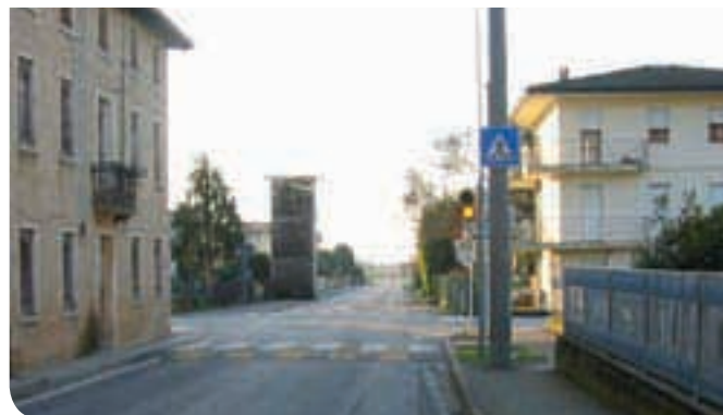
2011 - 2013 Dossi in asfalto - incrocio Caldoro
