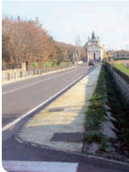
2012 - 2013 Realizzazione vialetti pedonali Villa di Maser
