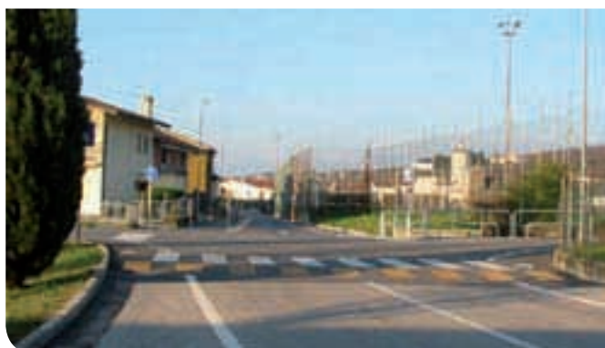
2011 - 2013 Dossi in asfalto - incrocio Metti
