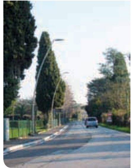
2012 - 2013 Rifacimento impianto pubblica illuminazione a Crespignaga
